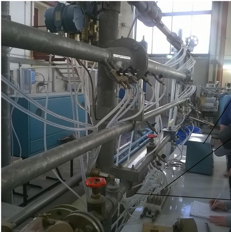
Prüfstand mit Messstellen , MessSchläuchen
